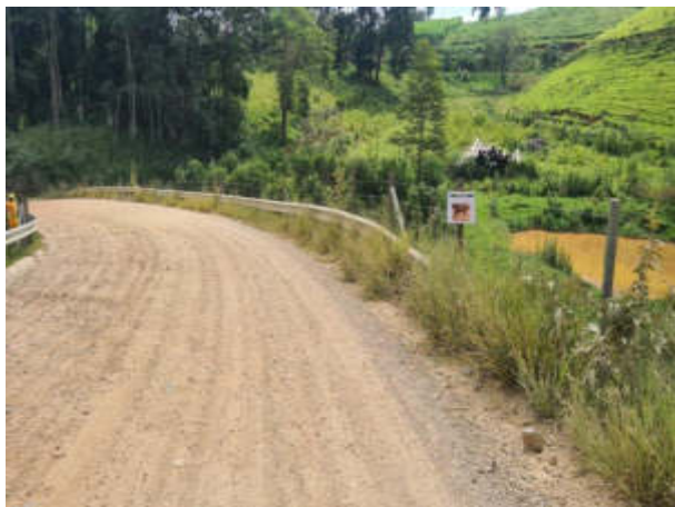
Foto 27 – Percurso percorrido na ADA do empreendimento. (Data: 26/03/2022).
