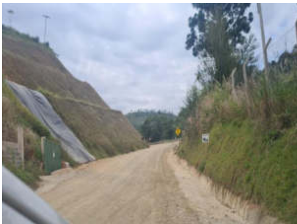
Foto 29 – Percurso percorrido na ADA do empreendimento. (Data: 09/04/2022).
