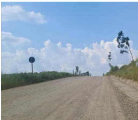
Foto 24 – Percurso percorrido na ADA do empreendimento. (Data:28/02/2022).
